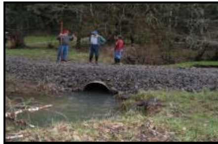
Impassable culvert on Eber Creek
